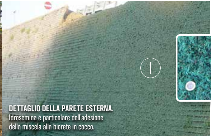
DETTAGLIO DELLA PARTE INTERNA DEL PARAMENTO. Si notano le dime d'angolo e i tiranti parzialmente interrati con terreno vegetale.
