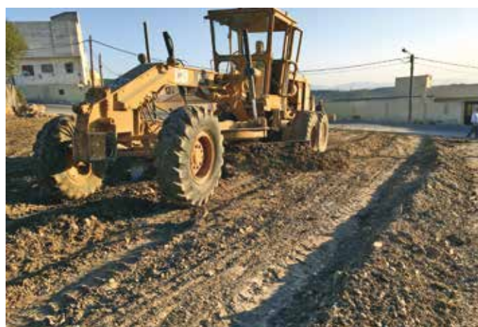
4. La miscelazione e la livellatura con grader
