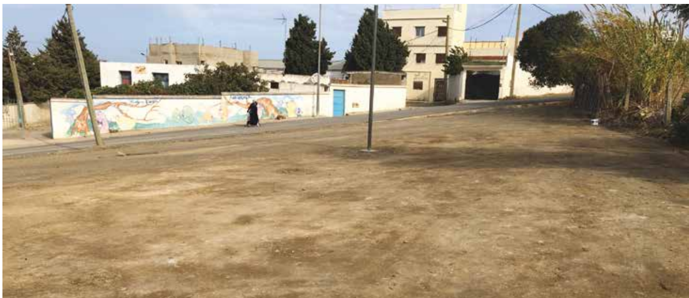
7. La pavimentazione al termine dei lavori
