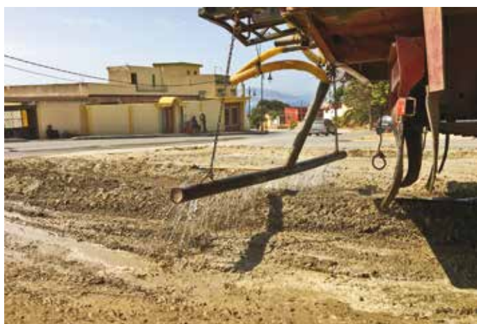
3. L'applicazione di 8 \text{ ml/m}^2 di Terra Plus diluiti in 2,5 \text{ l} di acqua
