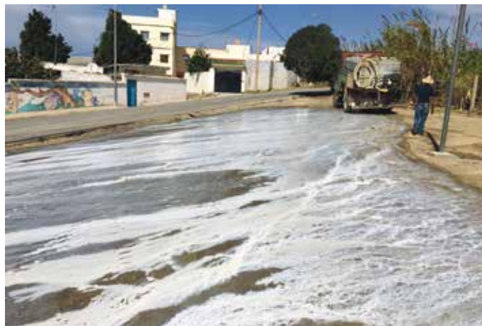
6. L'aspersione del Soil Sement di 0,7 l/m 2 diluiti in 6,3 l di acqua
