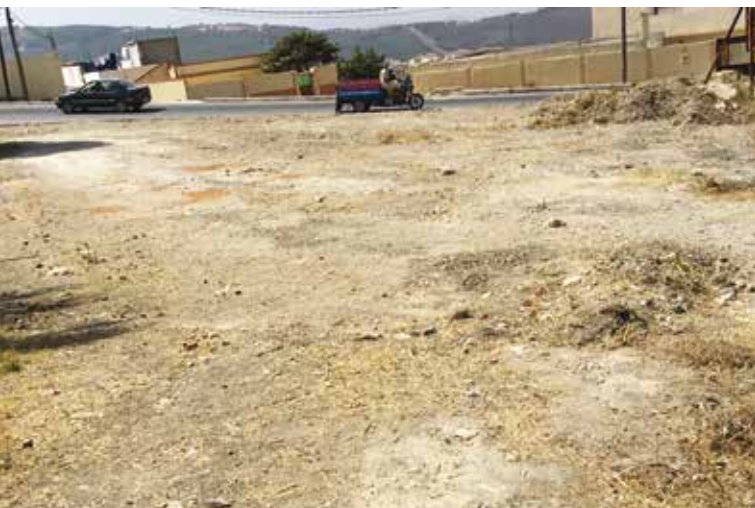
1. L'area di lavoro prima dell'intervento
