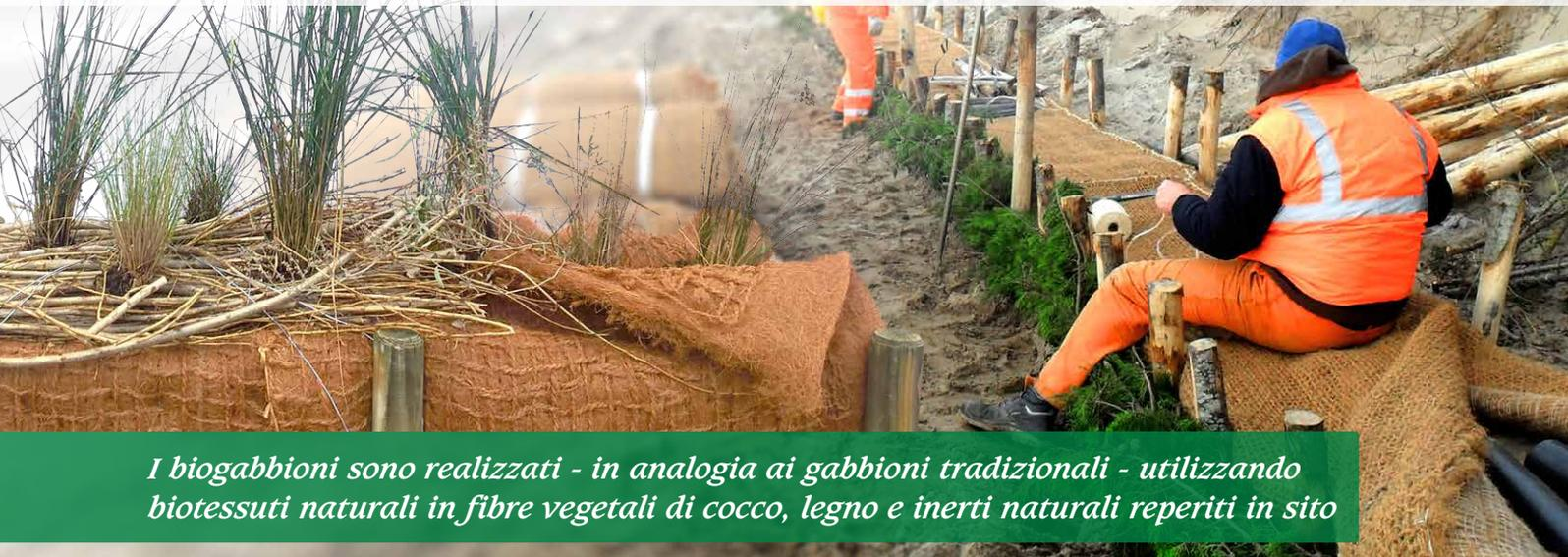
*I biogabbioni sono realizzati - in analogia ai gabbioni tradizionali - utilizzando biotessuti naturali in fibre vegetali di cocco, legno e inerti naturali reperiti in sito*
