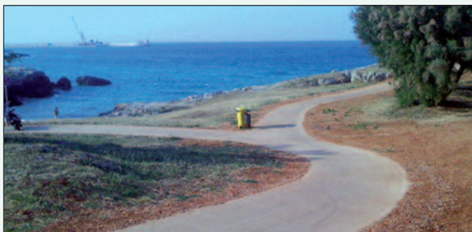
Figura 2 - Un'altra realizzazione di una pista ciclo-pedonale
