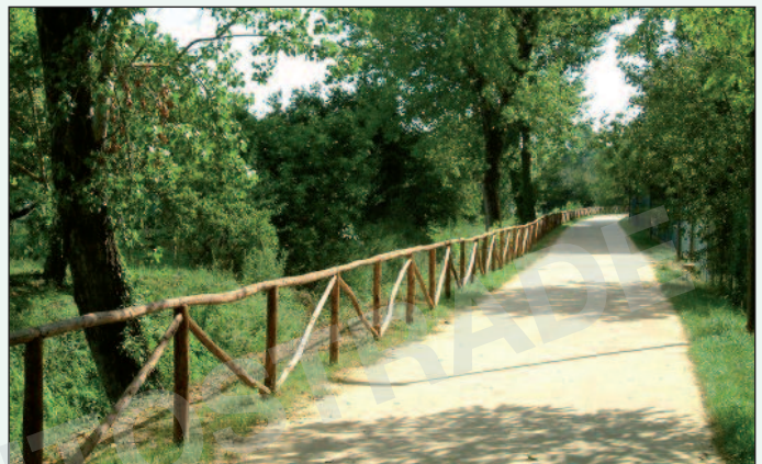
Figura 1 - Una ciclabile realizzata con Soil Sement
