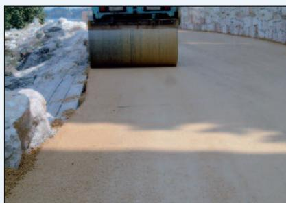
Figura 6 - L'aspersione dello strato anti-usura dopo la compattazione
