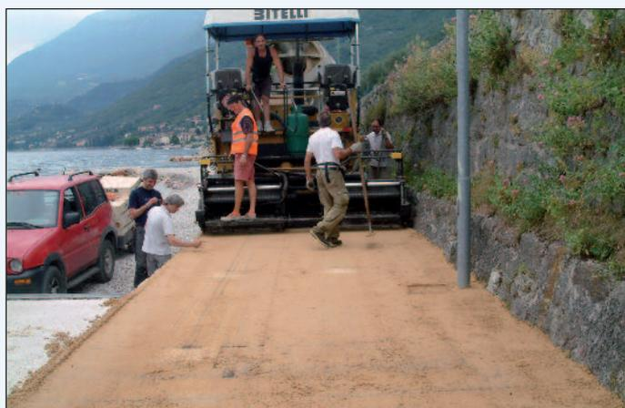
Figura 5 - La stesura dell'inerte bagnato con il Soil Sement NF® per mezzo della finitrice
