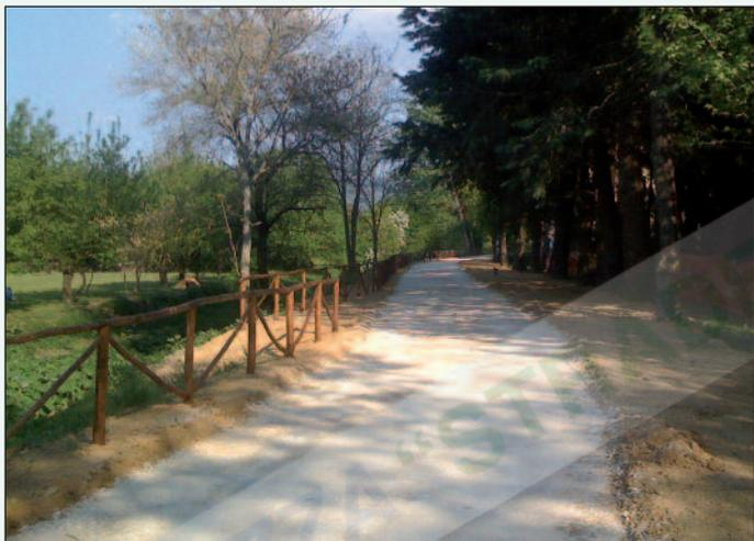
Figura 4 - Il sottofondo di stabilizzato compattato sul quale andrà posato il tappetino d'usura
