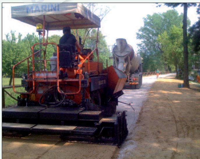
Figura 5 - L'inizio dello scarico degli inerti e la stesa mediante vibrofinitrice con piastre fredde e vibranti di 10 cm di soffice
