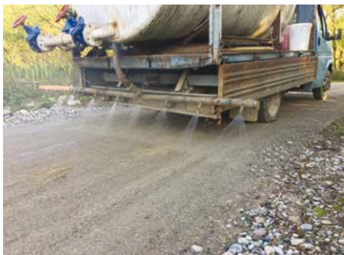
3. L'aspersione del Terra Plus diluito in acqua per la stabilizzazione su terreno A2-6 in sostituzione del cemento
