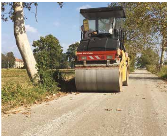
4. La compattazione del terreno trattato
