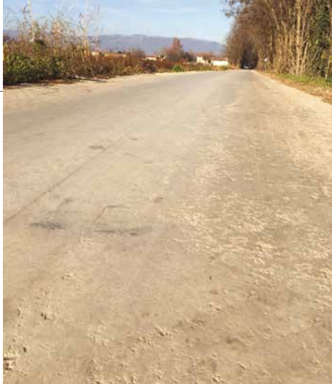
2A e 2B. Panoramica e dettaglio di una strada stabilizzata a cemento e trattata superficialmente con il Soil Sement NF 69
