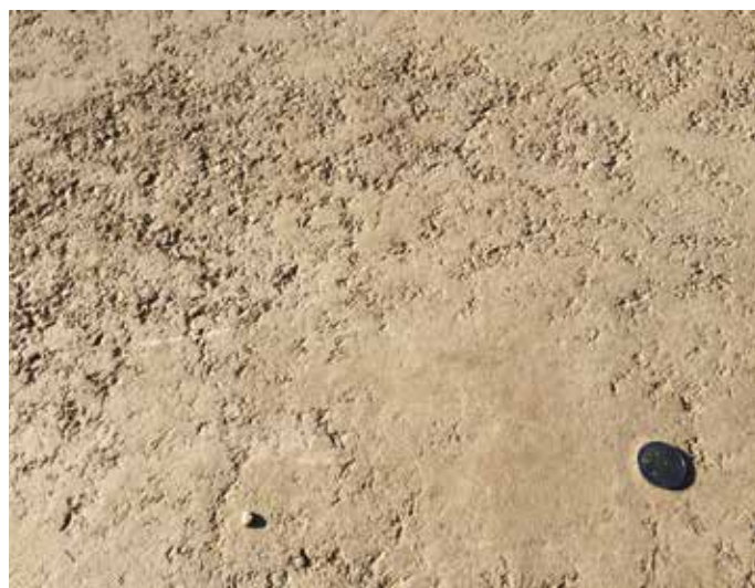
2A e 2B. Panoramica e dettaglio di una strada stabilizzata a cemento e trattata superficialmente con il Soil Sement NF 69
