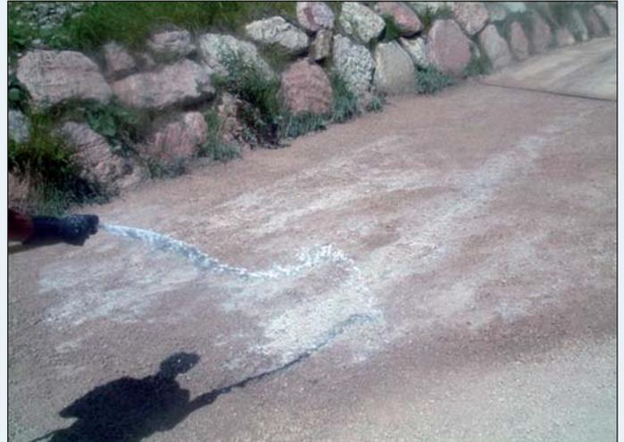
Figura 4 - La prima applicazione di Soil Sement® e di acqua
