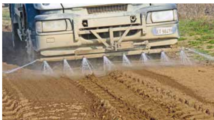
6. L'applicazione del Terra Plus
