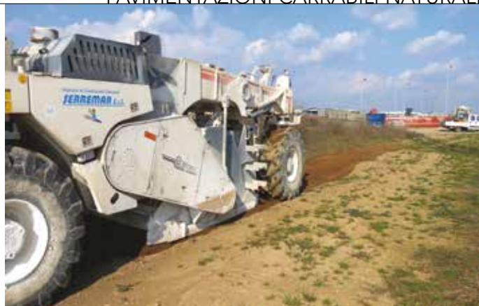
5. La fresatura del terreno spessore 20 cm
