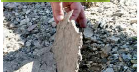
Particolare della crosta protettiva dopo 6 mesi
