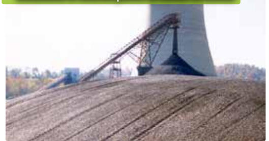
Trattamento di controllo polveri su cumulo di carbone
